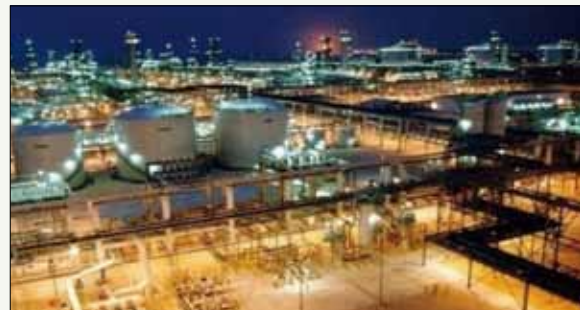
RAS LAFFAN PROJECT PHASE 6 & 7 Onshore LNG Plant
